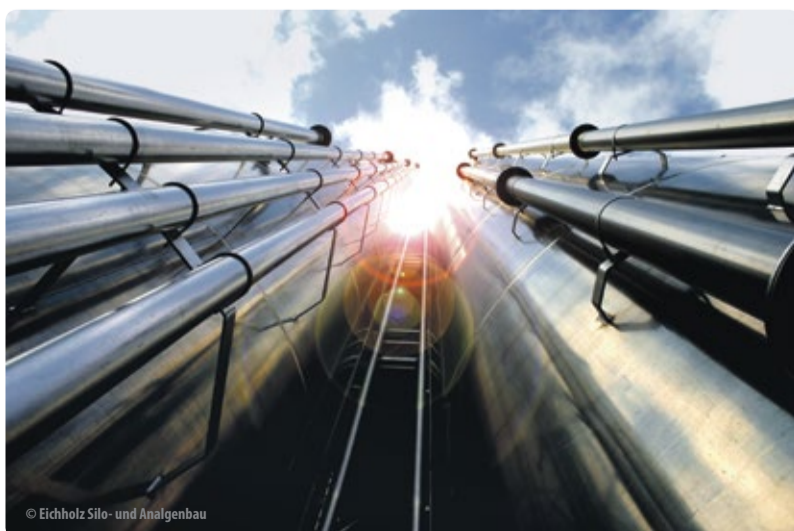
Bei Silos setzt Eichholz ausschließlich auf Aluminium- und Edelstahlkonstruktionen.
