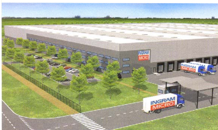
Wird zum Schutz vor Hochwasser 1,5 bis 2 m aufgeschüttet: Das neue Lager von Ingram Micro.
