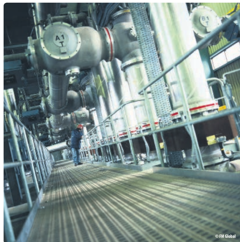
Durch ein gutes Risikomanagement lassen sich Gefahren in Chemieanlagen minimieren.
