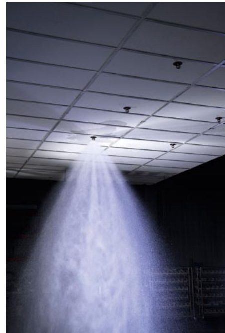
Das Schadenausmaß in gesprinklerten Bereichen fällt in der Regel vier- bis fünfmal geringer aus als in ungesprinklerten Bereichen
